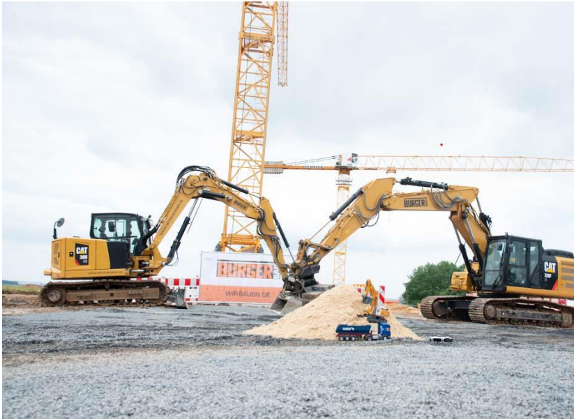
Die Bagger sind startklar.
